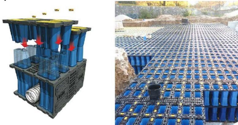
L'emprise au sol de la structure alvéolaire est d'environ 25 m<sup>2</sup>. Le système sera composé de 72 caquettes d'infiltration de dimensions 80x80x16 soit environ 28 m<sup>3</sup>.
